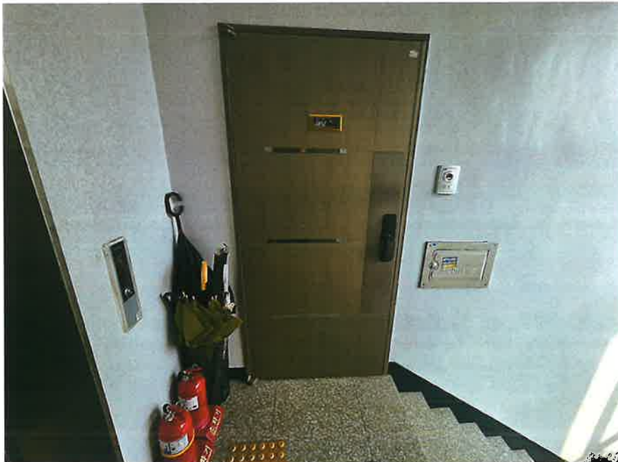
대상물건 일련번호 가) 출입문 촬영
